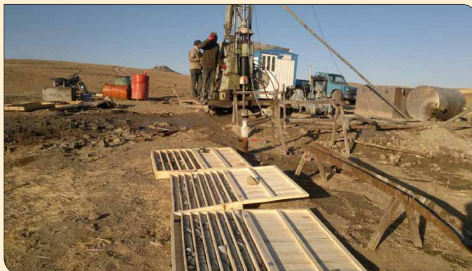
عملیات حفاری گمانه ها
